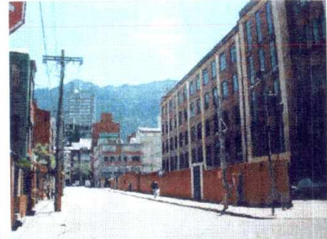
ALTERACIONES A LA EDIFICACION ORIGINAL VISIBLES DESDE EL EXTERIOR :
